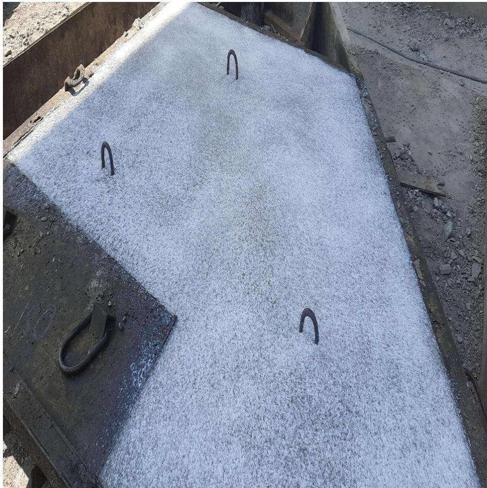
Пропитка для защиты свежеуложенного бетона Лотус БП – это однородный готовый к применению состав на основе парафиновой дисперсии и специальных добавок. Изготавливается в различных концентрациях.
