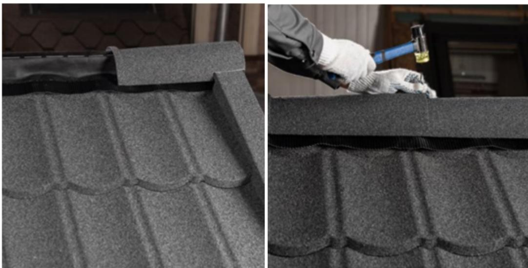
Коньковый брус сечением 50x50 мм (или 50x 75 мм) зафиксируйте саморезами к креплению конькового бруса. Верхний ряд панелей ската не является полноразмерным, поэтому подрежьте панель вдоль и спрофилируйте в тисках либо специальном станке опорную ступень для укладки на обрешетку. Фиксацию выкроенных панелей производите аналогично целым панелям.
