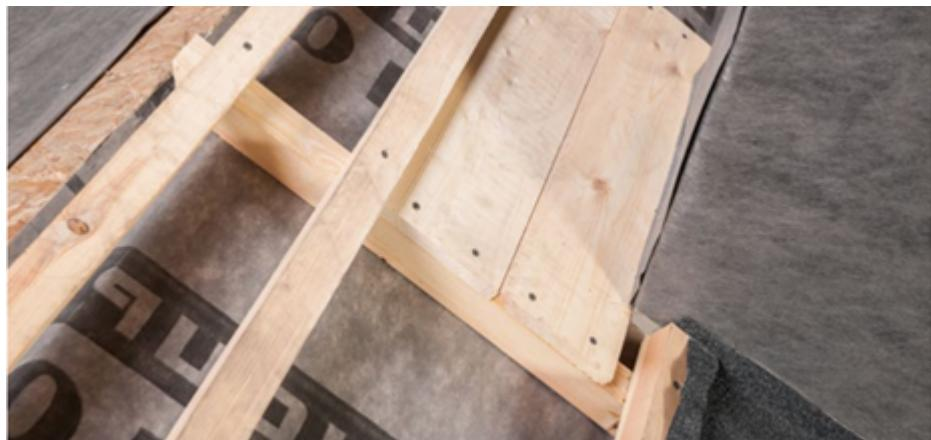
По периметру трубы смонтируйте прижимную планку с последующей механической фиксацией и герметизацией согласно схеме.
