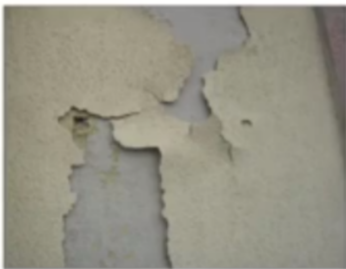
Гидроудар, акриловая штукатурка по каменной вате
