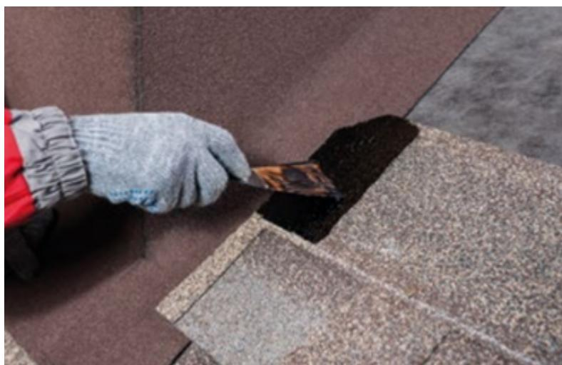
11. Произвести укладку гибкой черепицы с тыльной стороны. Гибкая черепица заводится на выкройку из ендового ковра таким образом, чтобы желоб между черепицей и галтелью был шириной 80 мм.
