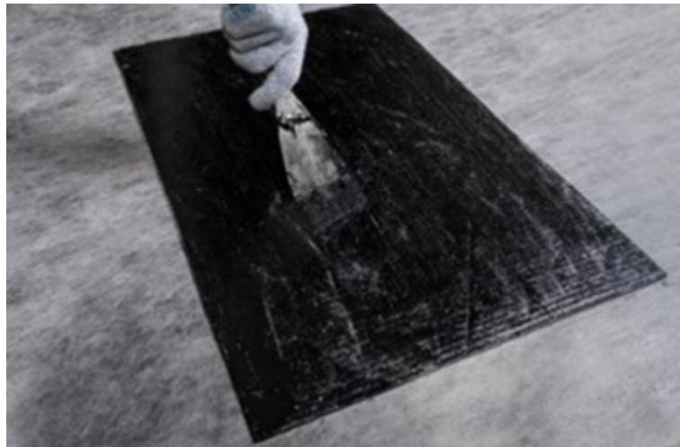
5. Поверх рядовой черепицы смонтировать полосы ендовного ковра ТЕХНОНИКОЛЬ: на прaimированную поверхность полоса заводится не менее чем на 300 мм\*, на рядовую черепицу – 200 мм.
