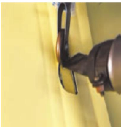
После того как проверочный канал «заглущен» посредством сварки, удалите непроверенную часть нахлеста для последующей установки заплатки.
