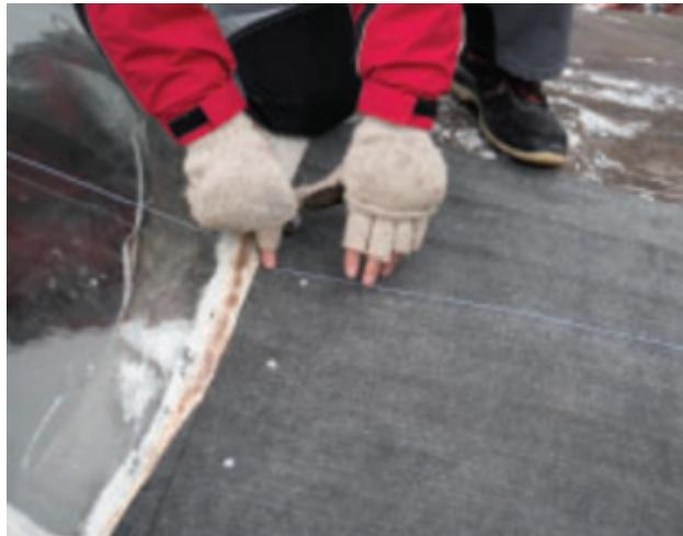
После монтажа первого вертикального ряда подкладочных ковров разметить сектор для обрезки подкладочных ковров: необходимо отбить шнуркой вертикальные линии от центра купола до каждого края подкладочного ковра в основании купола.
