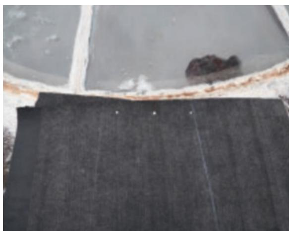
По полученному сектору подрезать подкладочные ковры. Оставшиеся отрезки можно использовать при монтаже последующих секторов.
