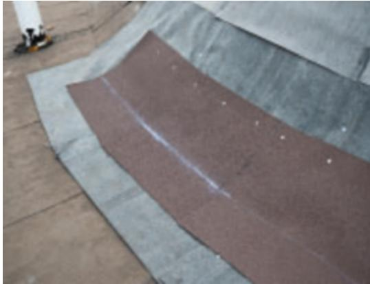
Отмечаем засечки каждые 330 мм на горизонтальной линии под шаг выкройки из гибкой черепицы.
