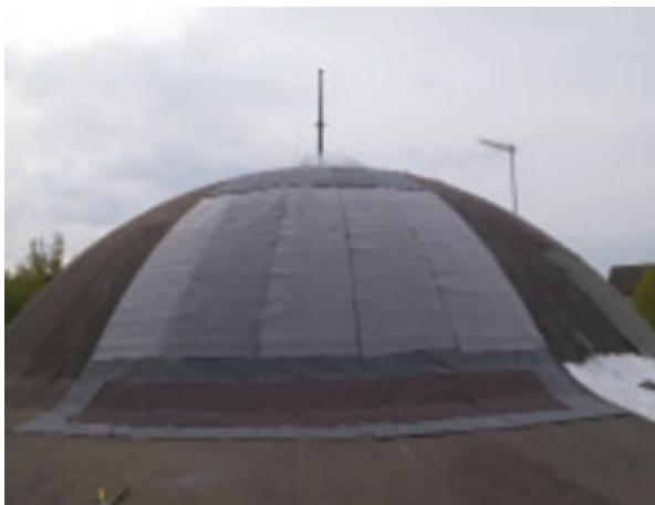
Промазать стартовую полосу выкройки из гибкой черепицы с тыльной стороны мастикой ТЕХНОНИКОЛЬ ФИКСЕР. Фиксируем каждую выкройку из гибкой черепицы 2 гвоздями.
