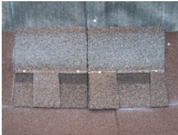
Монтируем последующие ряды гибкой черепицы, смещая швы гибкой черепицы на половину ширины выкройки. Подрезаем гибкую черепицу по вертикальным линиям разметки.
