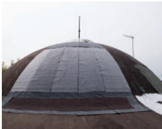
Разрезать гонт гибкой черепицы на 3 части - на выкройки по 330 мм.
