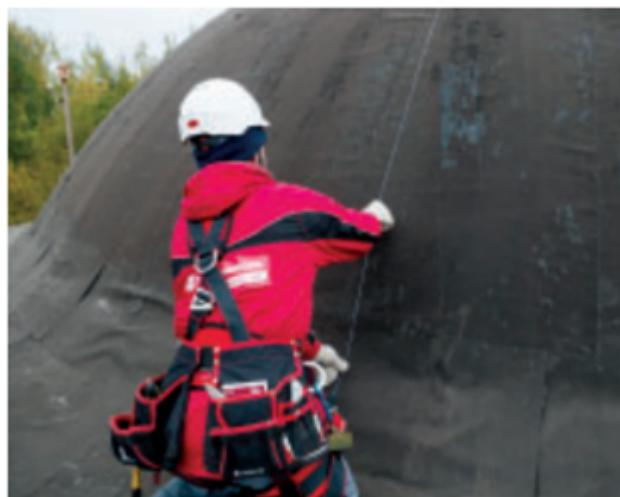
Нанести с помощью шнурки вертикальную линию разметки - от центра купола к отметкам на
