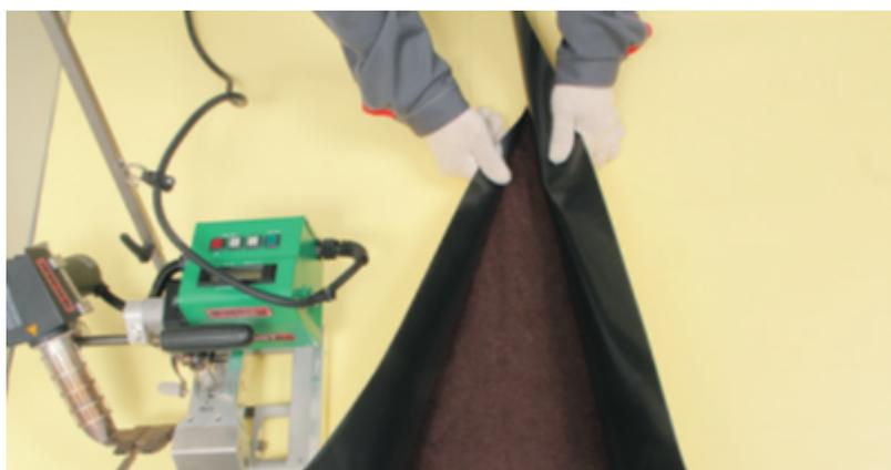
Установите сварочный аппарат на место начала сварки.
