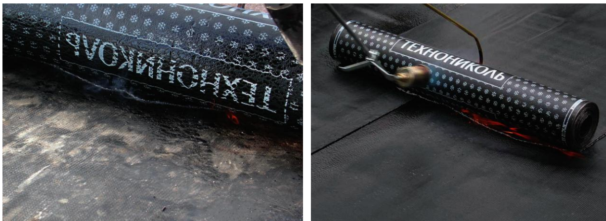
Рис. 9. Валик расплавленного битумно-полимерного вяжущего
