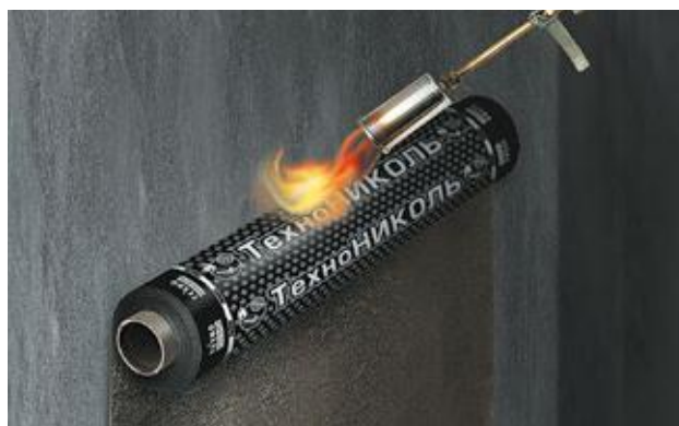
Рисунок 4.18. – Наплавление битумно-полимерного рулонного материала на вертикальную поверхность
