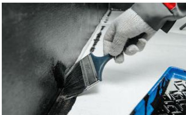
Рисунок 3.7. – Нанесение праймера кистью в зоне угла
