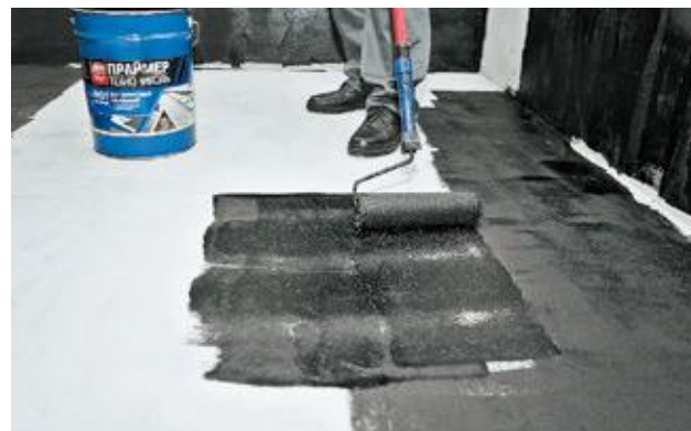
Рисунок 3.5. – Нанесение праймера
