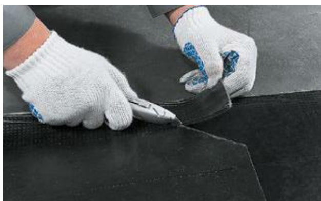
Рисунок 4.5. – Подрезка угла рулона в Т-образном шве
