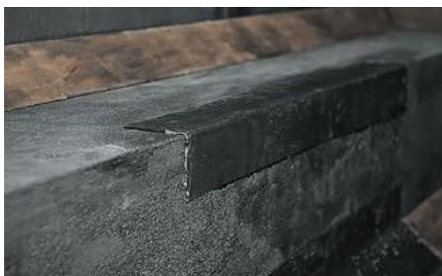
Рисунок 4.3. – Слои усиления на внешнем угле при смене плоскости наплавления
