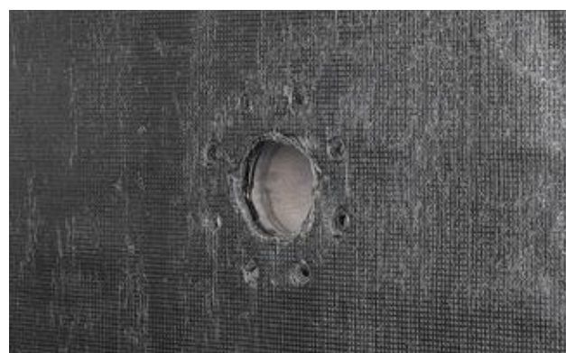
Рисунок 6.12. – Раскладка рулонов первого и второго слоя Техноэласт ЭПП в зоне трубной проходки
