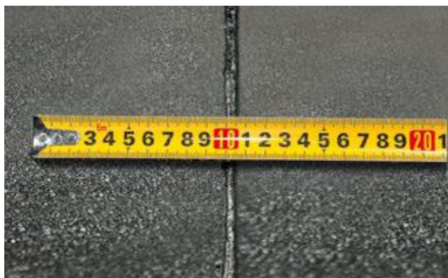
Рисунок 4.10. – Вытек битумного вяжущего из под кромки материала
