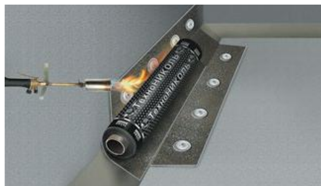
Рисунок 5.7. – Наплавление рулона на слой усиления
