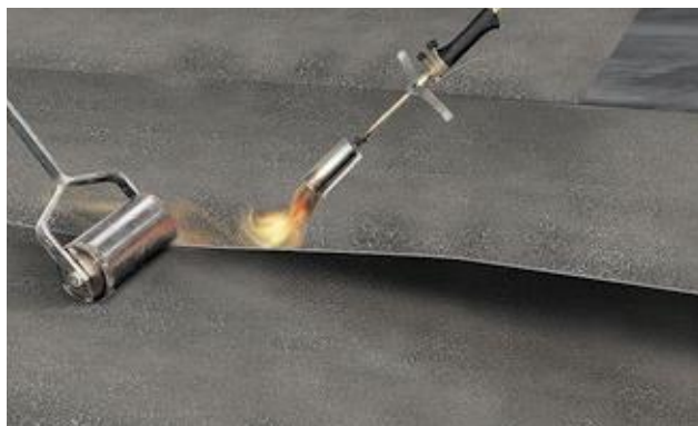
Рисунок 5.1. – Сварка рулонов в зоне нахлеста при свободной укладке материала
