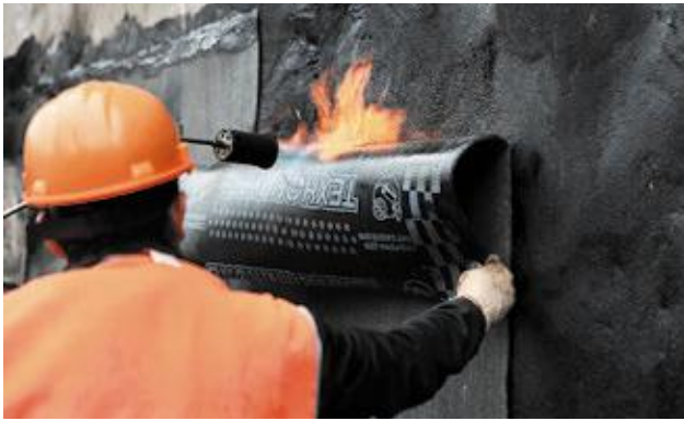
Рисунок 2.3. – Метод сплошного наплавления
