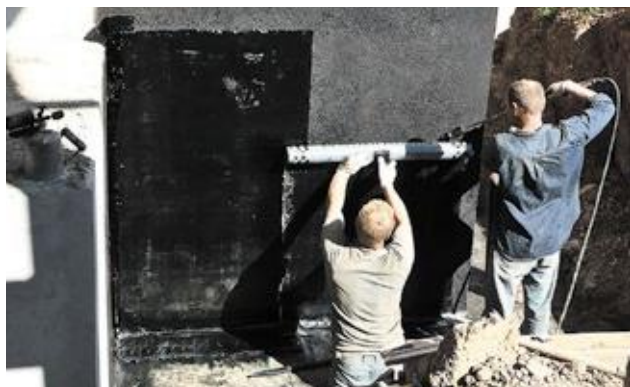
Рисунок 4.17. – Ручная и механическая подача рулона
