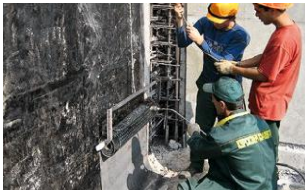
Рисунок 4.16. – Устройство слоев усиления в зоне трубной проходки и внешнего угла
