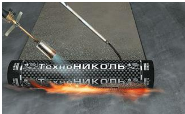
Рисунок 4.8. – Наплавление рулона
