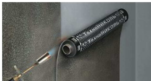
Рисунок 5.6. – Сварка нахлестов с последующей механической фиксацией рулона
