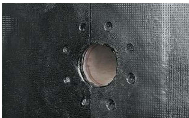
Рисунок 6.12. – Раскладка рулонов первого и второго слоя Техноэласт ЭПП в зоне трубной проходки
