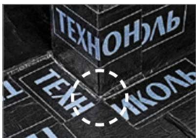
— Для дополнительной герметизации приклейте заплатку в место соединения угла стены (перегородки) и горизонтального основания.
