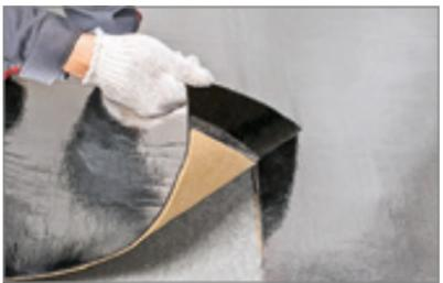
— Создание герметичного соединения в торцевых нахлестах соседних рулонов:
