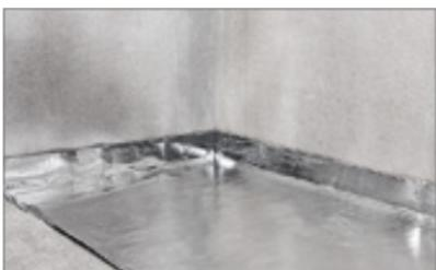
— При отсутствии демпферной ленты возможно заведение материала Техноэласт АКУСТИК СУПЕР на вертикальные поверхности на высоту финишного слоя напольного покрытия.
