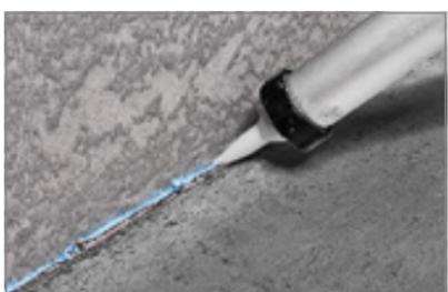
— При устройстве гидроизоляции загерметизируйте место соприкосновения демпферной ленты и вертикальной поверхности (несущие стены, перегородки, колонны и т. п.).
