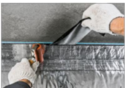
— Для предотвращения попадания ц/п раствора под демпферную ленту проклейте место сопряжения с материалом скотчем или самоклеящейся лентой-герметиком ТЕХНОНИКОЛЬ.
