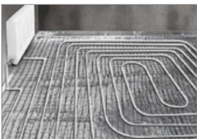
— При устройстве теплового пола с помощью водяного отопления, трубопровод можно закрепить к уложенной армирующей сетке.
