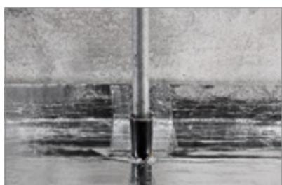
— Уложите материал Техноэласт АКУСТИК СУПЕР на общей плоскости, аккуратно подрезая материал, выполняя примыкание к трубе.
