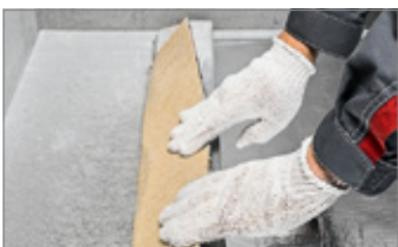
— Согните материал Техноэласт АКУСТИК СУПЕР, используя металлическую линейку или правило.
