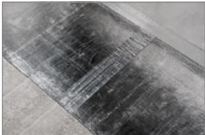
— Общий вид сформированного герметичного бокового и торцевого соединения соседних рулонов.
