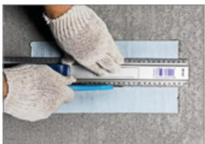
— Надрежьте пленку с нижней стороны самоклеящейся ленты-герметика по всей длине на две части – одна часть ленты будет наклеена на вертикальную поверхность, другая – на горизонтальную. На горизонтальную часть лента должна быть наклеена не менее чем 50 мм.
