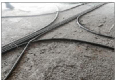
— Для укрытия электропроводки и трубопроводов необходимо выполнить дополнительный выравнивающий слой, который скрыл бы данные уложенные элементы.
