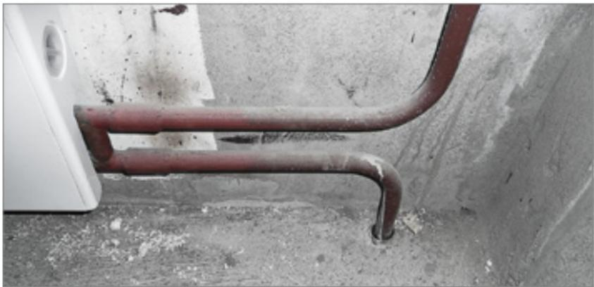
Гильза должна полностью изолировать трубу от междуэтажного перекрытия и напольного покрытия.
