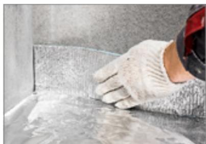
— Установите вплотную к углу демпферную ленту с одной стороны угла.
