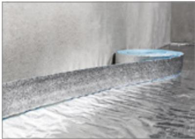
— В местах сопряжения стяжек с вертикальными конструкциями (стенами, перегородками, колоннами, проходящими через перекрытия, и т.п.), а также в местах дверных проемов, установите демпферную ленту.
