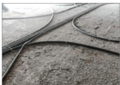
— При наличии на междуетажном перекрытии электропроводки или трубопроводов необходимо выполнить выравнивающую стяжку в соответствии с п.2.5.1.
