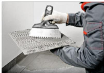
— Нанесите на плитку и на материал раствор и размажьте зубчатым шпателем.
