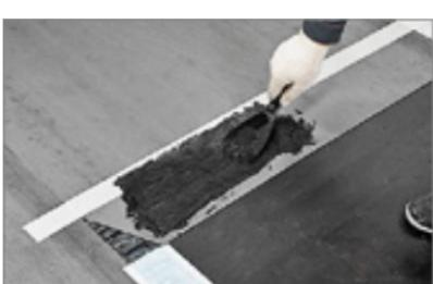
— Торцевой нахлест смежных рулонов должен составлять 150 мм.
