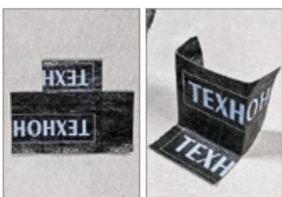
— Подготовьте заплатку по всей ширине стены (перегородки). Заплатка должна заходить на две стороны стены (перегородки) и на горизонтальную часть основания на 80–100 мм.
