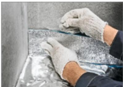
— При использовании самоклеящейся демпферной ленты удалить съемную пленку и приклейте ленту к вертикальной конструкции.
