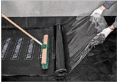
— Для удобства приклейки материала на основание перекрытия вам понадобиться помощник: один человек вытягивает съемную пленку на себя и, таким образом, разматывает рулон, а второй – приглашает материал с помощью щетки.
