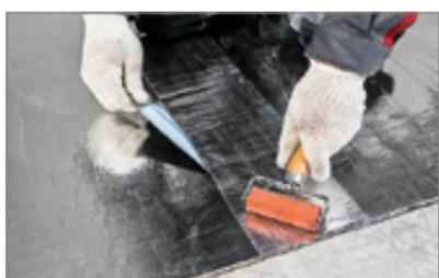
— При проклейке самоклеящейся лентой-герметиком швов торцевые нахлесты формируются встык друг к другу.
