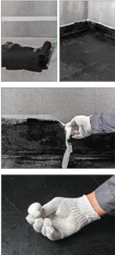
— Основание для укладки материала Техноэласт БАРЬЕР обработайте праймером ТЕХНОНИКОЛЬ №04.
