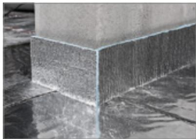
— Установите демпферную ленту по ширине вертикальной поверхности.
