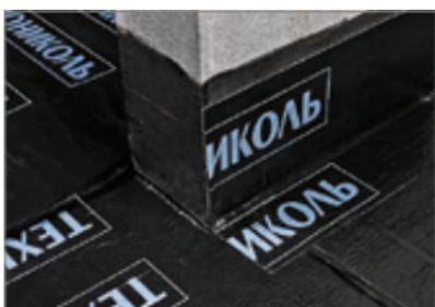
— Приклейте материал с двух сторон вертикальной конструкции (стена, перегородка) на высоту не менее 200 мм.
