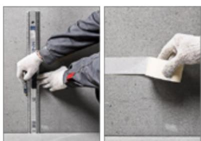
— На вертикальные стены перед нанесением грунтовки наклейте по всему периметру малярную ленту.
