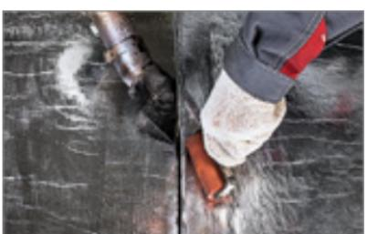
— Одновременно разогревайте промышленным феном боковой шов и прокатывайте силиконовым роликом.
