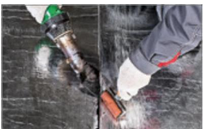
— Для создания герметичного соединения в боковых швах и торцевых стыках рулонов, сварите нахлести при помощи промышленного фена горячего воздуха.
