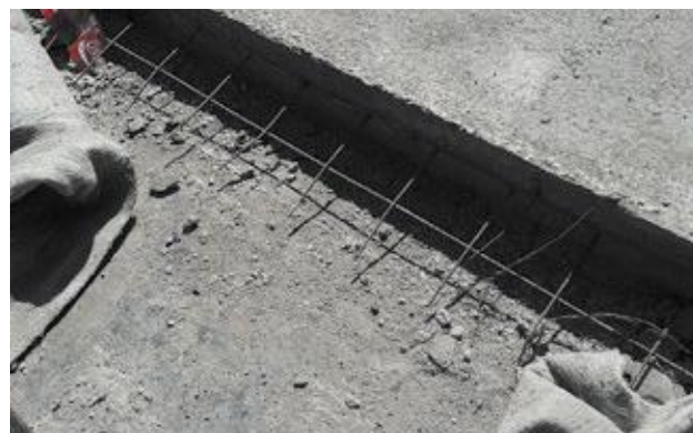
Рисунок 4.11. – Защитная стяжка
