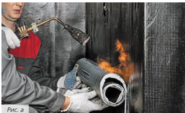
Рисунок 2.2. – Двухслойная гидроизоляционная мембрана Техноэласт ЭПП (рис. а) и однослойная гидроизоляционная мембрана Техноэласт ТЕРРА (рис. б)
