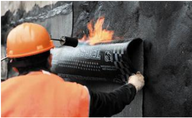
Рисунок 2.3. – Метод сплошного наплавления
