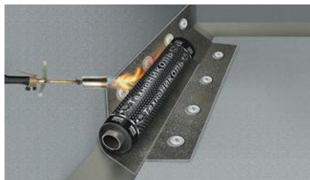
Рисунок 5.7. – Наплавление рулона на слой усиления
