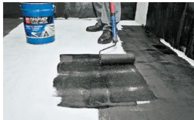
Рисунок 3.5. – Нанесение праймера
