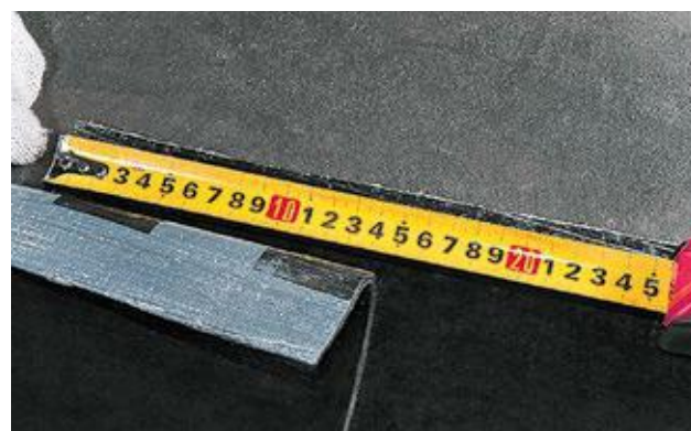
Рисунок 4.4. – Контроль торцевого нахлеста при укладке материала Техноэласт ЭПП
