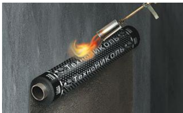
Рисунок 4.18. – Наплавление битумно-полимерного рулонного материала на вертикальную поверхность
