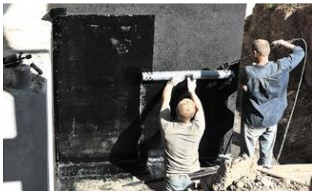
Рисунок 4.17. – Ручная и механическая подача рулона
