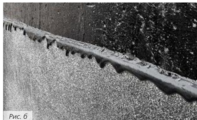
Рисунок 2.2. – Двухслойная гидроизоляционная мембрана Техноэласт ЭПП (рис. а) и однослойная гидроизоляционная мембрана Техноэласт ТЕРРА (рис. б)
