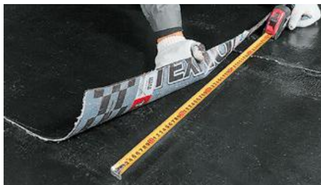
Рисунок 4.13. – Выставление нахлеста между рулонами первого и второго слоев
