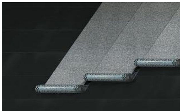
Рисунок 4.15. – Укладка рулонов второго слоя перпендикулярно рулонам первого слоя
