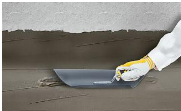
Рисунок 3.3. – Устройство выкружки
