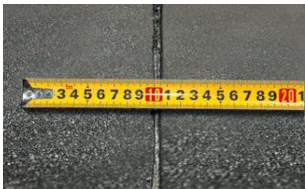
Рисунок 4.10. – Вытек битумного вяжущего из под кромки материала
