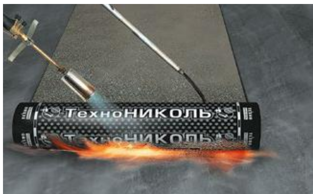
Рисунок 4.8. – Наплавление рулона
