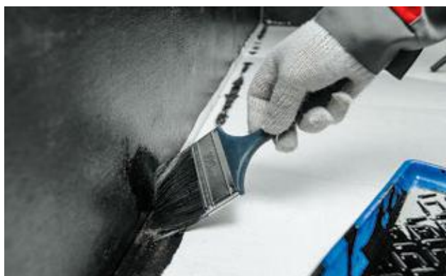
Рисунок 3.7. – Нанесение праймера кистью в зоне угла
