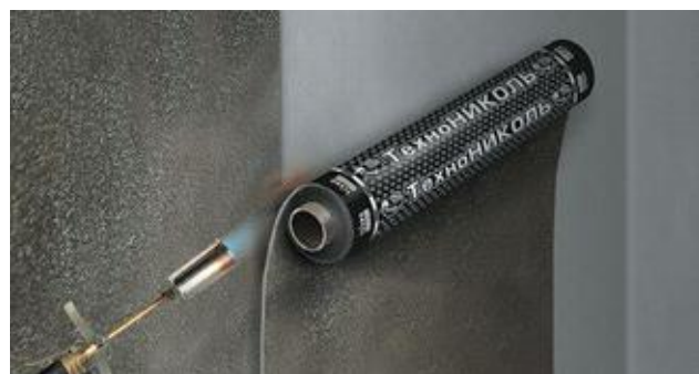
Рисунок 5.6. – Сварка нахлестов с последующей механической фиксацией рулона
