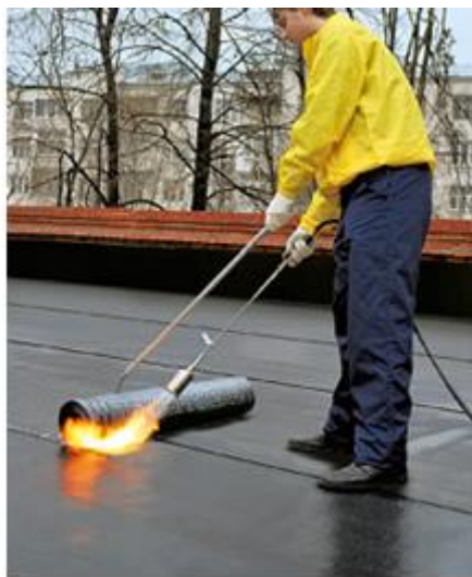
Рисунок 4.9 – Положение рабочего при наклейке рулона
