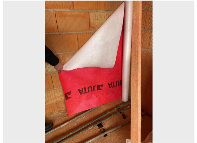
☑ В конструкции крыши с холодным чердаком нет необходимости в гидроветрозащитной мембране непосредственно под кровельным покрытием. Если же смонтирована гидро-ветрозащитная мембрана в конструкции крыши с холодным чердаком, то она не должна препятствовать работе вентиляции чердачного пространства.
