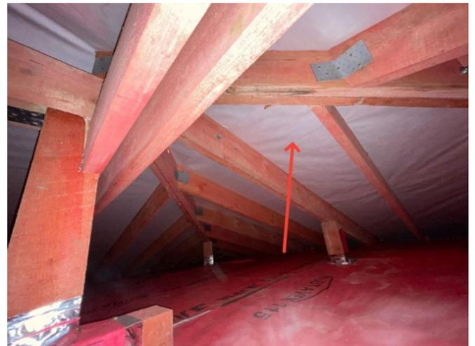
❗ Точечные аэраторы. Нарушена работа вентиляции чердачного пространства - вытяжка воздуха перекрыта гидро-ветрозащитной мембраной.
