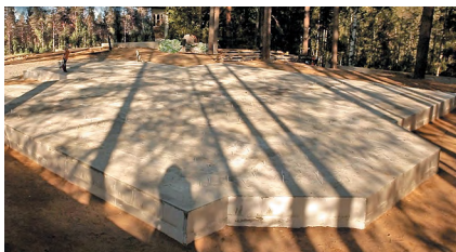
Готовая поверхность плиты
