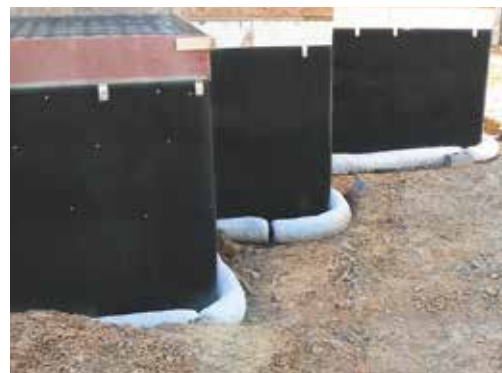
Защита гидроизоляции и дренаж
