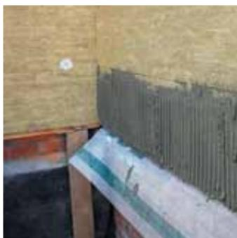
Свободную часть сетки шириной 200 мм завернуть и закрепить на утеплителе при формировании базового штукатурного слоя сразу после приклейки теплоизоляции. Последующий элемент «конверта» выполняют встык к предыдущему без нахлеста полотен сетки.
