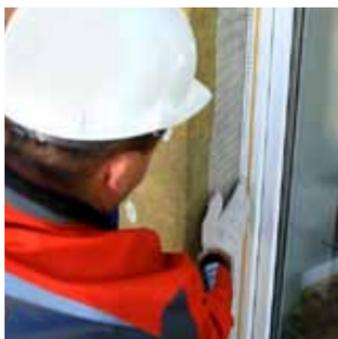
На поверхности оконной рамы для создания необходимого примыкания системы к оконной раме, сокращения времени работы, исключения возникновения трещин и предохранения окна от загрязнения рекомендуется устанавливать примыкающие профили.
