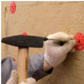
Дюбель вставляют в отверстие и добивают молотком. После закрепления дюбелей в них нужно вбить (вкрутить) распорные наконечники. При забивании распорного анкера следует исключить возможность его повреждения.
