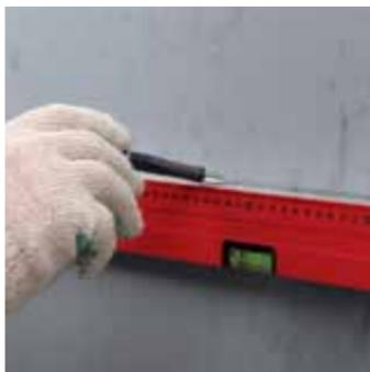
Монтаж опорного (цокольного) профиля следует выполнять в соответствии с проектом, горизонтально, в одной плоскости, прикрепляя его к основанию анкерами с полимерным дюбелем. Расстояние между точками установки анкеров не должно превышать 300 мм.
