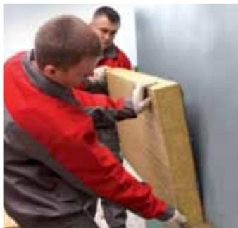
После нанесения клея плита приклеивается к стене в обозначенном месте. После чего прижимается ударами длинной теркой. При этом необходимо контролировать положение плиты по горизонтали и вертикали. Если клеевой раствор выступит за пределы плиты, его нужно убрать, чтобы не образовывались температурные «мостики».
