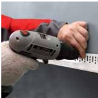
Не допускается соединение опорного (цокольного) профиля внахлест. Соединение элементов опорного (цокольного) профиля осуществляется при помощи соединительных элементов.
