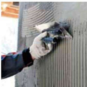
При создании армированного базового штукатурного слоя необходимо соблюдать следующую последовательность технологических операций:
