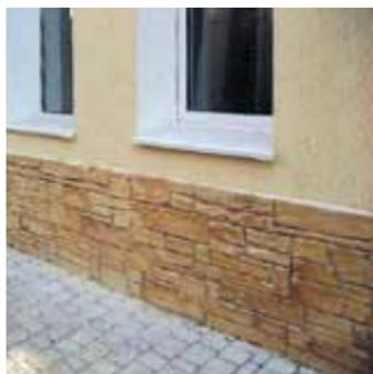
Перед плиточной облицовкой необходимо устройство дополнительного слоя усиленной стеклосетки, закрепленной фасадными дюбелями в количестве не менее 2 шт./м<sup>2</sup>. Дополнительное дюбелирование следует производить по «мокрому» слою клея. Дополнительный слой усиленной фасадной сетки монтируется поверх базового штукатурного слоя, армированного рядовой сеткой.
