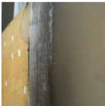
Армирующую сетку запрещается укладывать непосредственно на теплоизоляционный слой. Сетка должна располагаться внутри клеевого слоя и не просматриваться на его поверхности.
