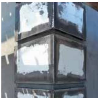
Декоративные элементы на плоскости фасада рекомендуется выполнять из фасадного пенополистирола. Элементы приклеиваются к поверхности фасада на базовый штукатурный слой, после чего крепятся на тарельчатый дюбель необходимой длины. Их следует также армировать при помощи специальных пластиковых профилей и архитектурной сетки.
