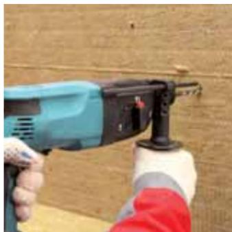
**Механическое крепление теплоизоляционных плит (дюбелирование)** (выполняется не ранее, чем через 24 часа после монтажа плит). Механическое крепление теплоизоляционных плит соответствующими анкерами выполняют только после полного высыхания клеевого состава (с учетом инструкции производителя) в соответствии со схемой установки.
