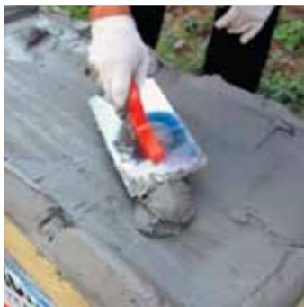
клеевого состава. Полоса клеевого состава, наносимого по контуру плиты, должна иметь разрывы для исключения образования воздушных пробок.
