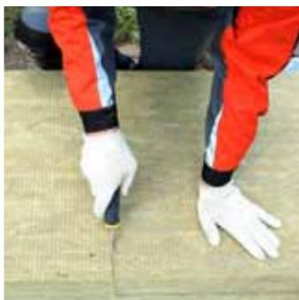
Раскрой теплоизоляционных плит проводят при помощи стальной линейки, угольника, ножа с широким лезвием или специальной пилы по утеплителю ТехноНИКОЛЬ. Крепление теплоизоляционных плит необходимо выполнять с использованием клеевых составов, готовых к применению или приготовленных из сухой строительной смеси. Клеевые составы
