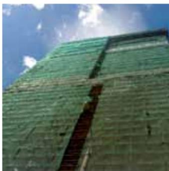
Производить укрытие лесов на участке выполнения работ необходимо при помощи установленной на лесах ветрозащитной сетки и полиэтиленовой пленки для защиты от прямого солнечного излучения и возможных атмосферных осадков. Наличие сетки дополнительно способствует безопасному проведению работ для прилегающей
