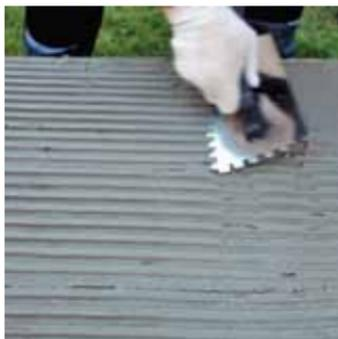
При применении теплоизоляционных плит из каменной ваты ТЕХНОФАС Л используется только сплошной метод нанесения клея.
