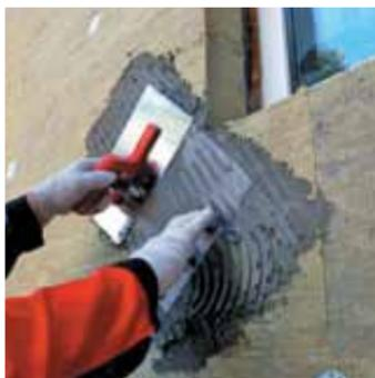
Вершины углов оконных и дверных проемов необходимо дополнительно усилить прямоугольными полосками из армирующей сетки размерами не менее 200 x 300 мм под углом 45° в следующем порядке:
