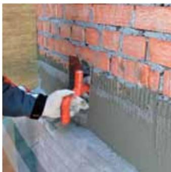
Вдоль опорного элемента к фасаду приклеить стеклосетку, ширина которой равна 400 мм + толщина утеплителя. К фасаду приклеить элемент «конверта» 200 мм стеклосетки. Один элемент «конверта» рекомендуется выполнять шириной 1000–1100 мм.
