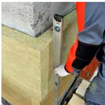
Правильность установки каждой теплоизоляционной плиты в проектное положение контролируют уровнем длиной 2 м.
