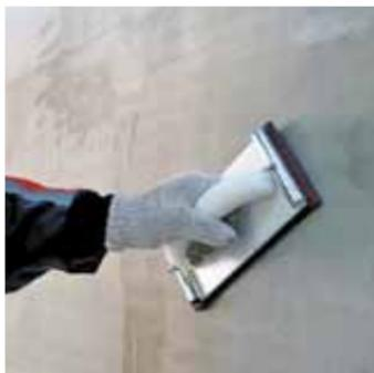
К нанесению внешнего декоративного слоя можно приступать только после полного высыхания защитного армированного слоя, но не ранее чем через 72 часа (при температуре окружающей среды 20 °С и относительной влажности воздуха 60 %). Армированный слой, представляющий собой основание под высококачественную штукатурку, должен быть
