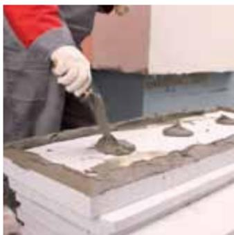
Крепление плит следует производить аналогично креплению теплоизоляции всей фасадной системы на полимерцементный клей либо любой другой, обеспечивающий хорошую адгезию к основанию, также возможно крепление плит на приклеивающую мастику.
