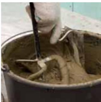
Растворная смесь должна быть израсходована в течение 1,5 часов с момента приготовления. В процессе работы в смесь нельзя добавлять воду. Для поддержания её пластичности её можно еще раз перемешать.
