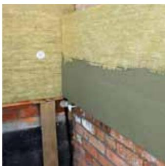
После окончания монтажа плит теплоизоляции временную опору рекомендуется удалить не ранее, чем через 72 часа. После чего можно приступить к утеплению и отделке цокольной части здания.
