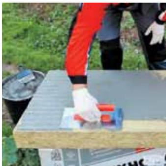
В целях увеличения адгезии вне зависимости от метода нанесения клеевой смеси необходимо провести обязательную подготовку поверхности утеплителя. Перед нанесением основного слоя на утеплитель необходимо нанести слой клеевого состава, который необходимо вдавить и растереть ровным краем стальной терки по всей поверхности.
