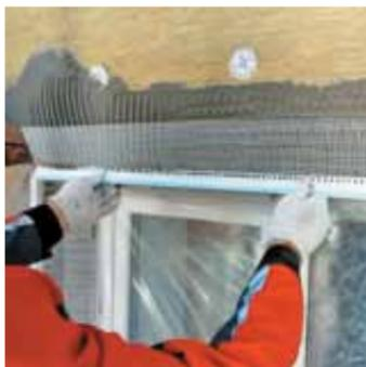
Для укрепления углов необходимо нанести клеевой раствор на поверхность плиты при помощи зубчатой терки. Затем установить угловой пластиковый профиль (профиль капельник по верхнему откосу), утопив его в растворе. Вдоль профиля необходимо уложить стеклосетку так, чтобы она заходила на обе плоскости от угла не менее чем на 150 мм и утопить ее
