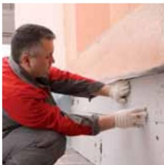
Плиты экструзионного пенополистирола с наружной стороны должны быть защищены от активного воздействия солнечных лучей. Также рекомендуется в цокольной части здания обеспечить дополнительную антивандальную защиту.
