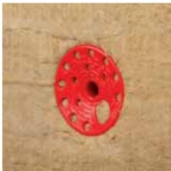
При правильном укреплении дюбелей их головки должны быть в одной плоскости с каменной ватой (не выступать и не быть вдавленными).
