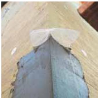
Усиливающие элементы устанавливаются перед устройством базового штукатурного слоя. Внешние углы здания, а также углы оконных и дверных проемов усиливаются профилями угловыми с сеткой. Профили устанавливаются встык по отношению друг к другу с нахлестом сетки в местах стыка минимум на 100 мм следующим образом:
