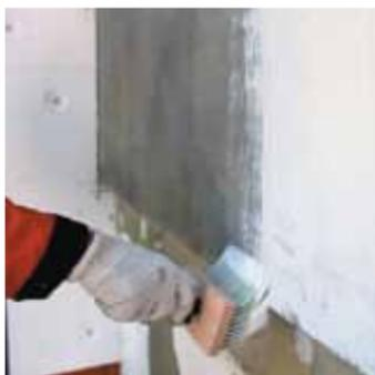
Перед нанесением декоративного слоя поверхность необходимо загрунтовать адгезионной грунтовкой. Грунтовку наносят на поверхность армированного базового штукатурного слоя кистью равномерным слоем за один проход, возможно механизированное нанесение в соответствии с инструкцией изготовителя материала.
