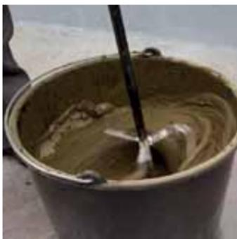
После получения требуемой консистенции смесь следует оставить на 5 минут, затем еще раз перемешать. Перемешивание стоит производить с помощью ручного электроинструмента (дрели) с насадкой для вязких растворов смесей при скорости вращения 400–800 об./мин.
