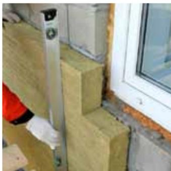
На углах оконных и дверных проемов следует устанавливать теплоизоляционные плиты с угловым вырезом таким образом, чтобы стыки швов между примыкающими плитами находились на расстоянии не менее 100 мм от угла проема.
