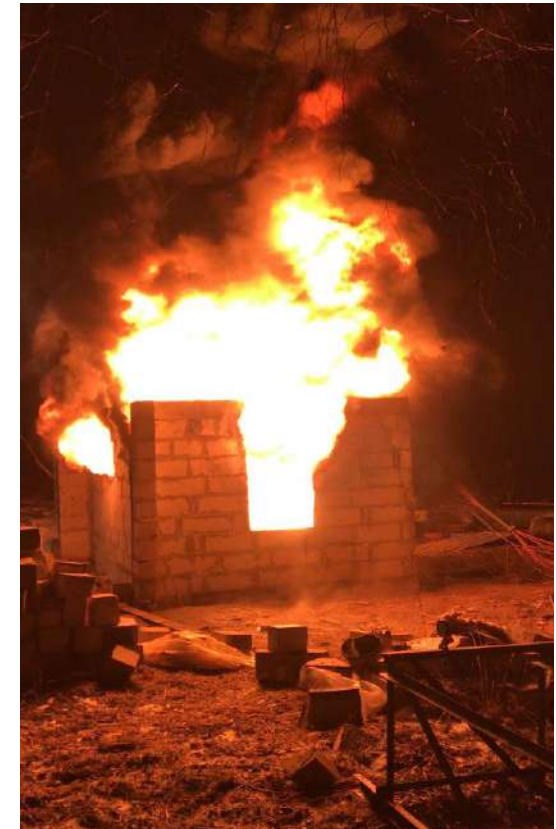
б – боковой фасад (окончание испытания)
